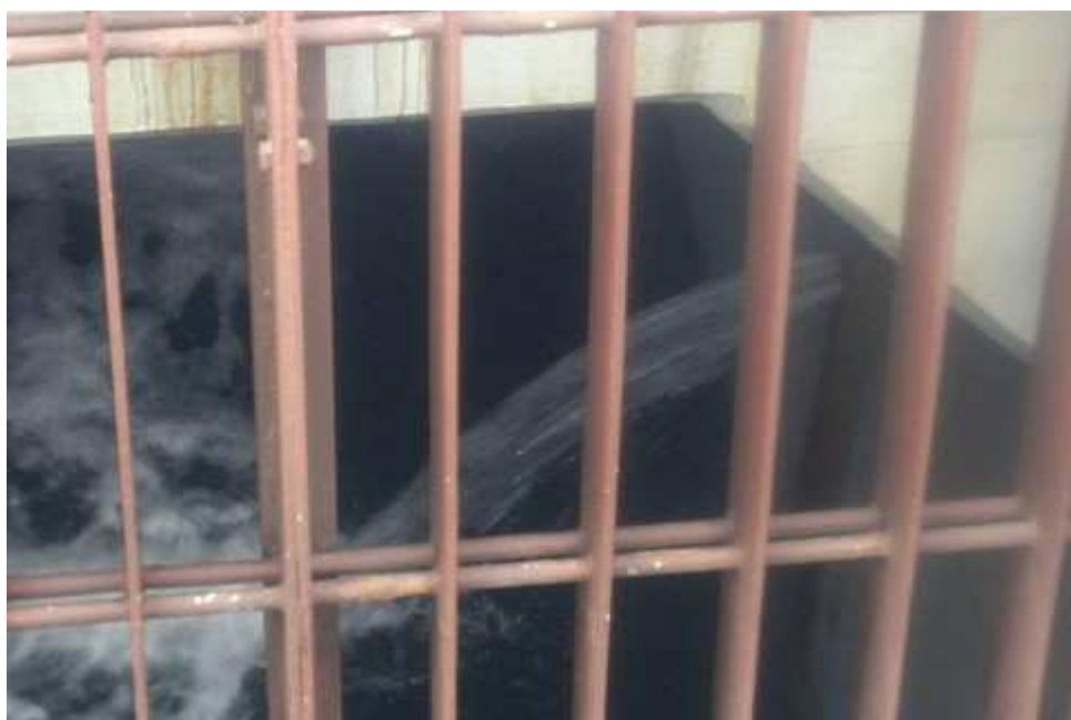
شکافی در دیواره رآکتور 2 , آب شدیداً آلوده اتمی به اقیانوس می ریزد.
